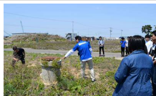
飛び出したマンホール
